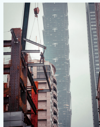
COVER PHOTO BY JIMMY LIAO 在 PEXELS 的作品。建築工人站在台北 101 大樓前的鋼樑上。
